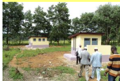
Les nouveaux blocs de latrines à l'école de Thialere - 13/09/17
