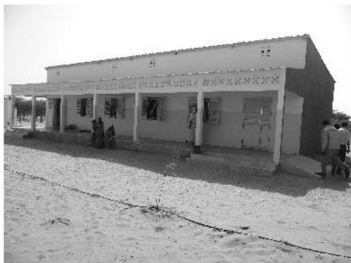
Salles de classe construites lors de l'intervention dans l'école de Démizine
