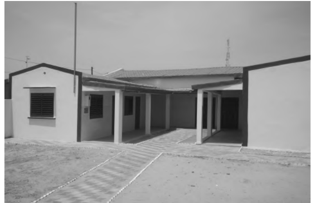
Fin de la construction de la case de Rosso en août 2013
