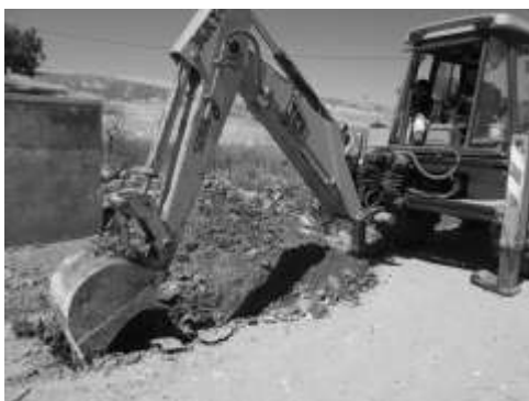
Début des travaux
