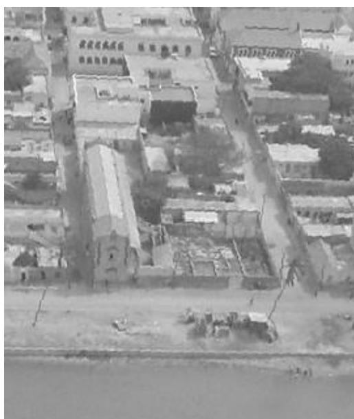
Vue de la parcelle après la destruction de l'immeuble administratif en 1990
