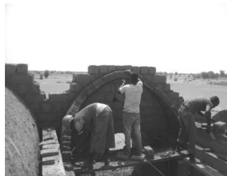
Réalisation de 2 salles de classes à Saldé en voûte nubienne (département de Podor).
