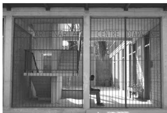
Entrée du bâtiment
