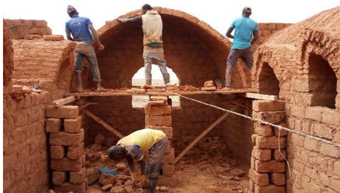
Exemple de bâtiment construit grâce à la technique de Voûte Nubienne
