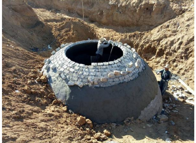
Construction de la cuve de méthanisation à Laâounate
