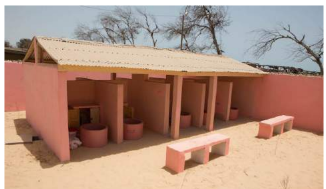
L'unité semi-industrielle de production de biogaz
