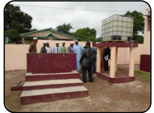
Borne-fontaine et château d'eau
