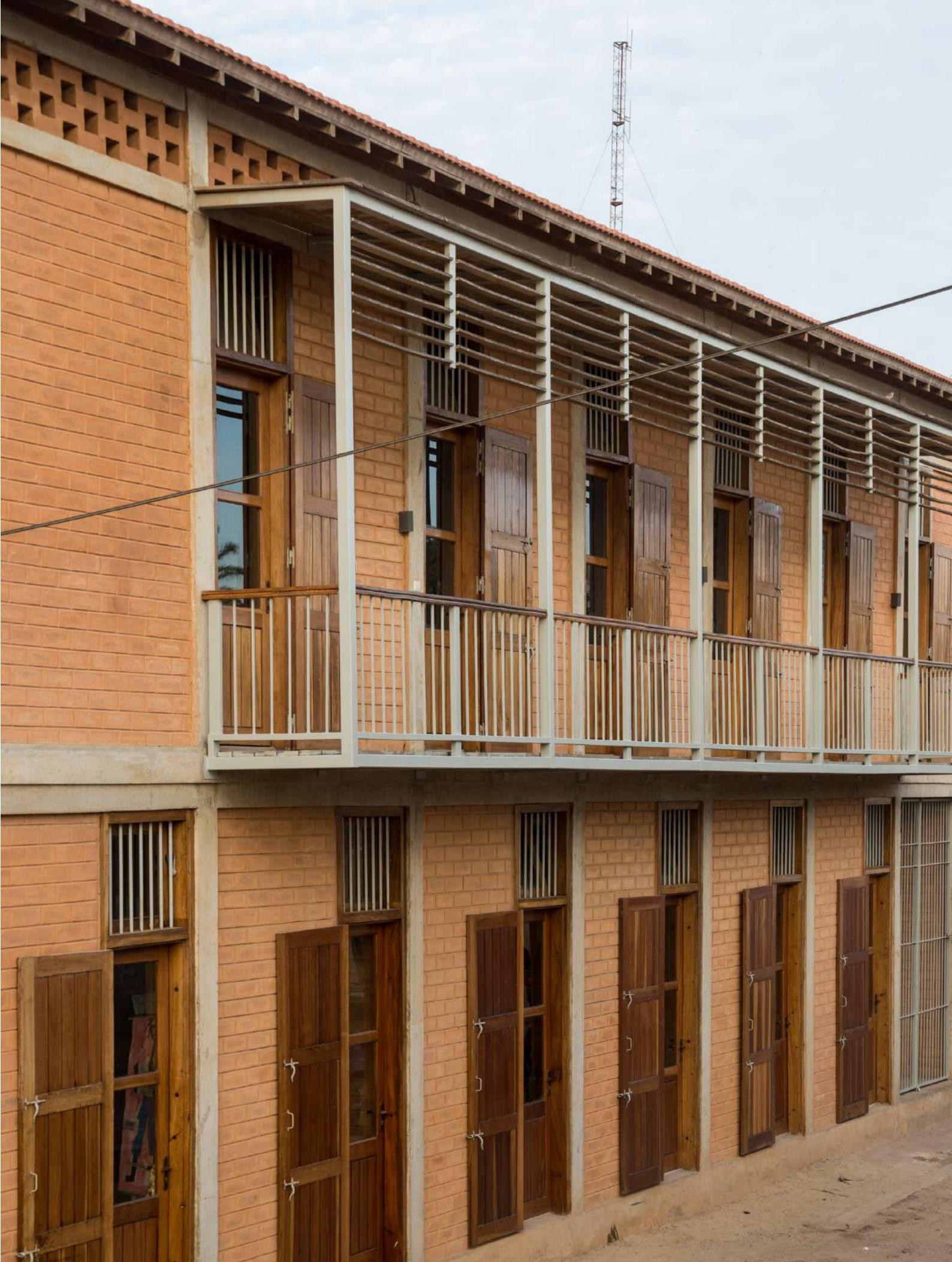
Le bâtiment Diapalante à Saint-Louis : les locaux du Partenariat au Sénégal et du centre de formation et d'insertion professionnelle « Diapalante ».
