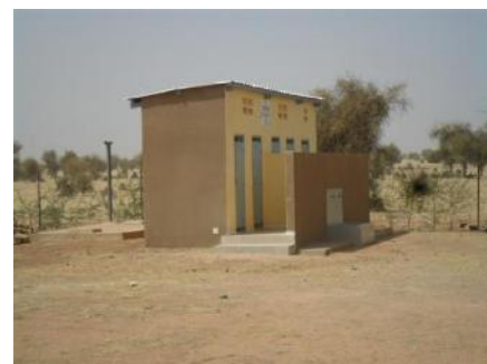
Exemple d'infrastructures réalisées dans une école : borne-fontaine, latrines, clôture
